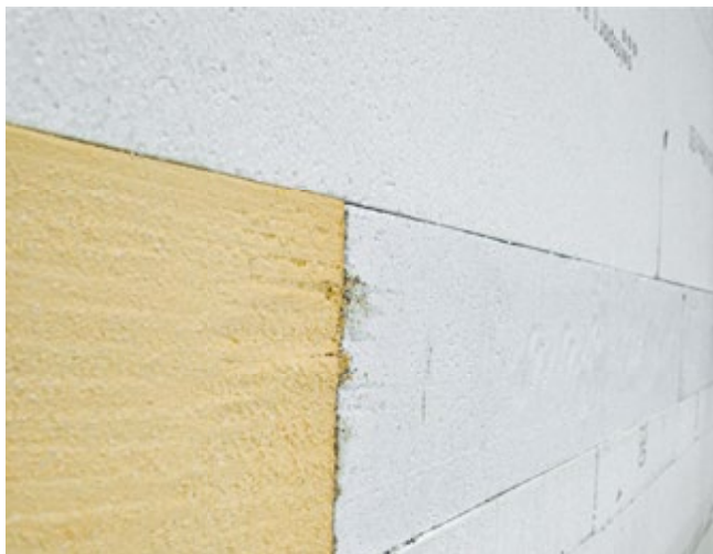
La mise en œuvre des bandes coupe-feu assure la protection incendie du bâtiment.
