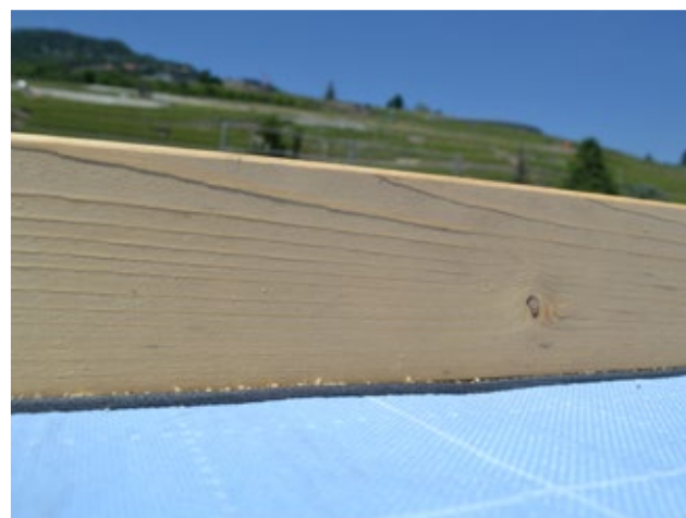
La bande caoutchouc assure l'étanchéité du système lors du vissage des lattes à travers l'isolation et la sous-couverture.
