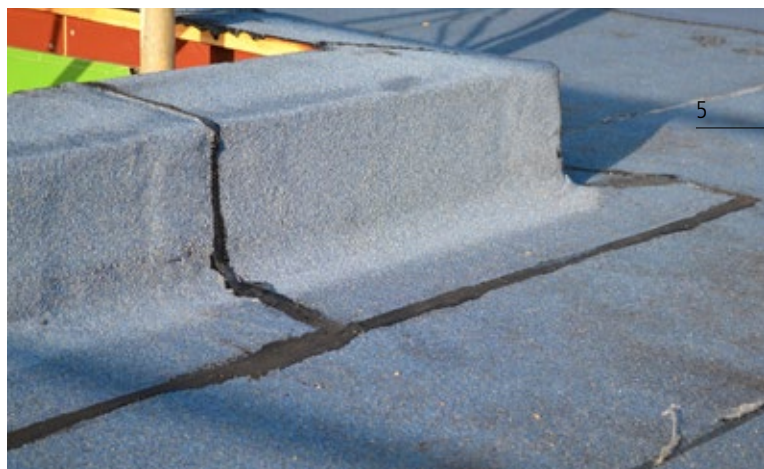
Détail de raccord par Dentan SA à Morges (VD)
