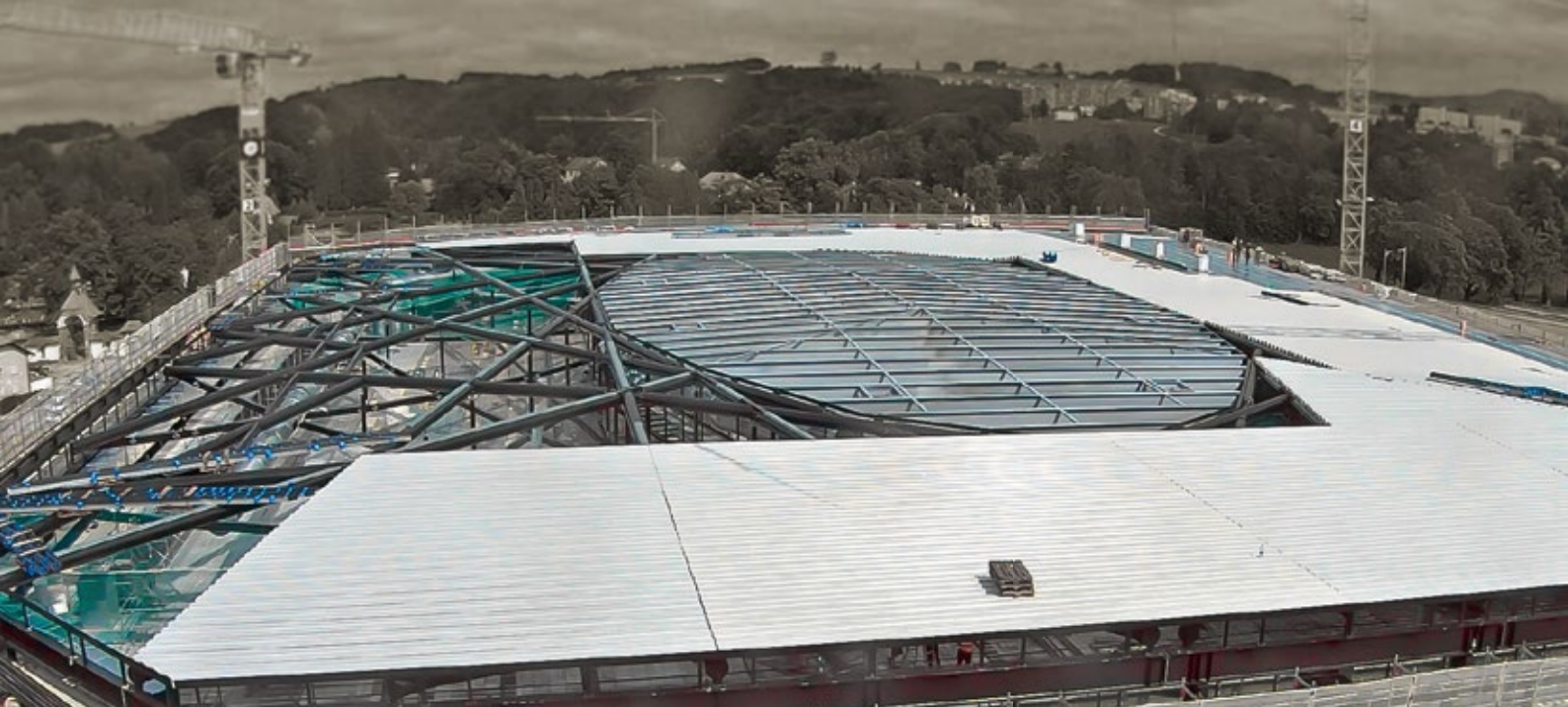
Pose de la sous-construction qui va recevoir le système d'étanchéité.
