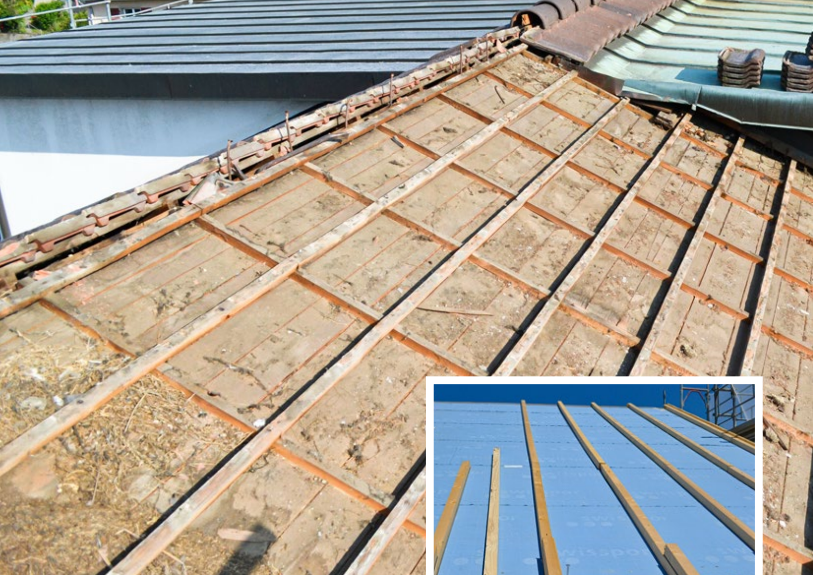
Une fois l'isolation posée, les raccords de la sous-couverture sont soudés et les lattes sont mises en place.
