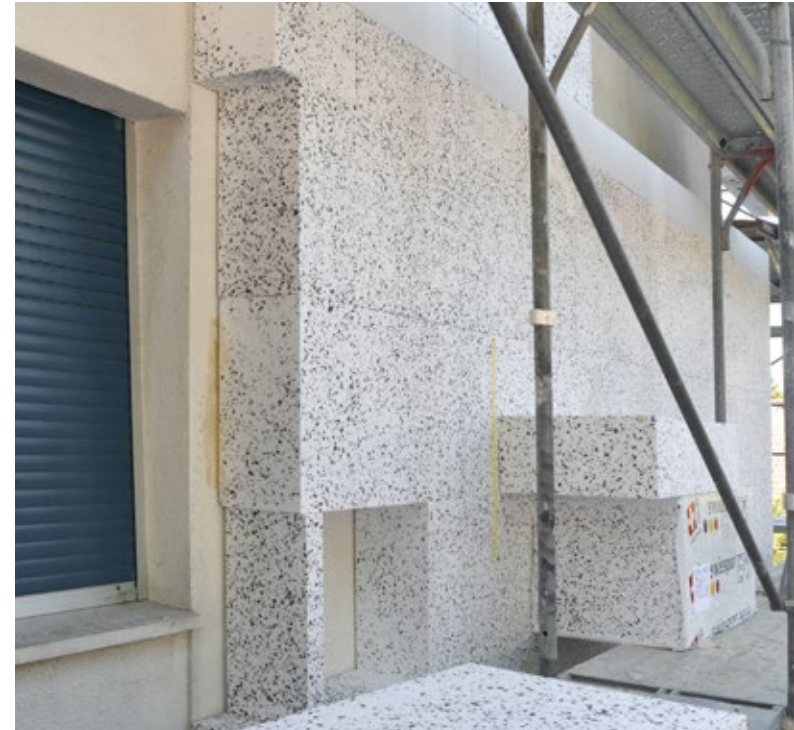
Le système d'isolation de façade est posé rapidement sur la façade existante.
