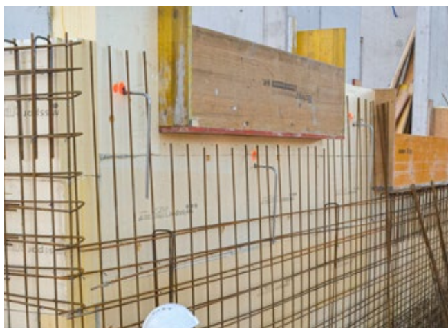
Préparation du coffrage avant de couler le béton. Le swissporXPS est mis en place à l'intérieur du ferrailage.
