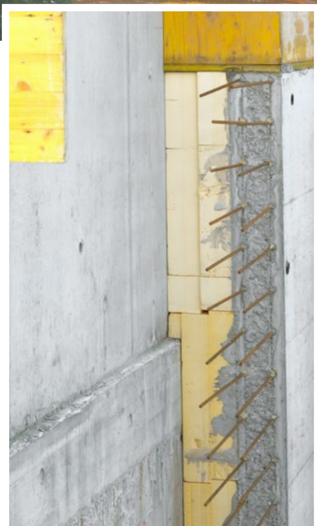
En coupe, le coffrage fini avec le doublage en béton.
